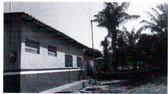
Foto 2 – Fachada Lateral Direita
